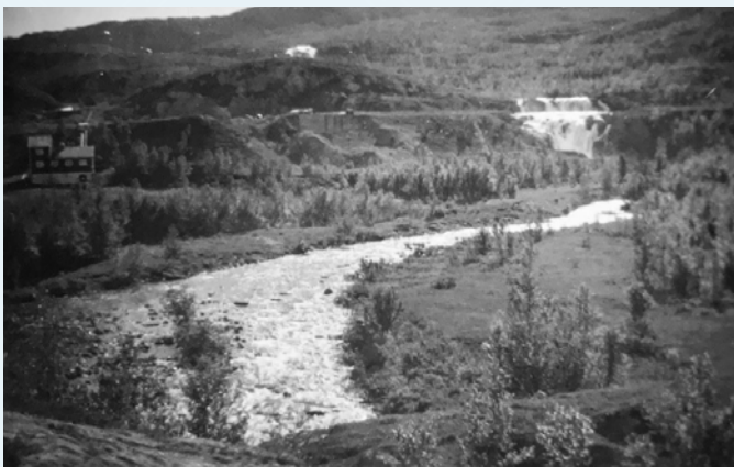
Porsaelva slik den var før den ble lagt i rør, til venstre skimtes den nye kraftstasjonen.
