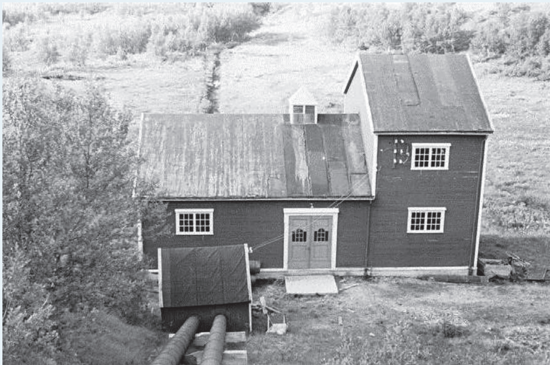
Kraftverket med rørgate som går inn i stasjonen 1939.
