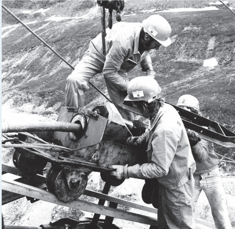
Høyt henger arbeiderne, når kablene trekkes over sundet. Noen havnet i sjøen, fra opptil 40 m, men ingen menneskeliv gikk tapt. Foto:FD arkiv
