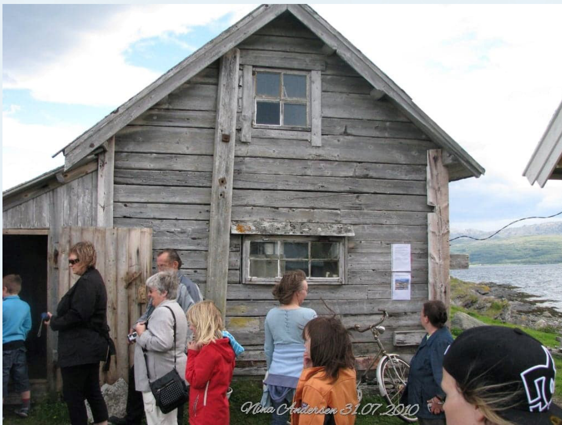
Fra Pedersen etterkrigshus i Klubbukt ved byggedager 2010
