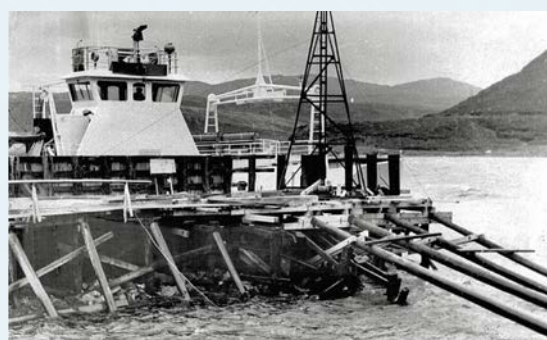
På begynnelsen av 70-tallet var trafikken blitt så stor at det var nødvendig å bygge to nye fergekaier i tillegg til de to som allerede var i bruk. De nye kaiene ble tatt i bruk før de strengt tatt var helt ferdige, som man kan se av dette bildet.
