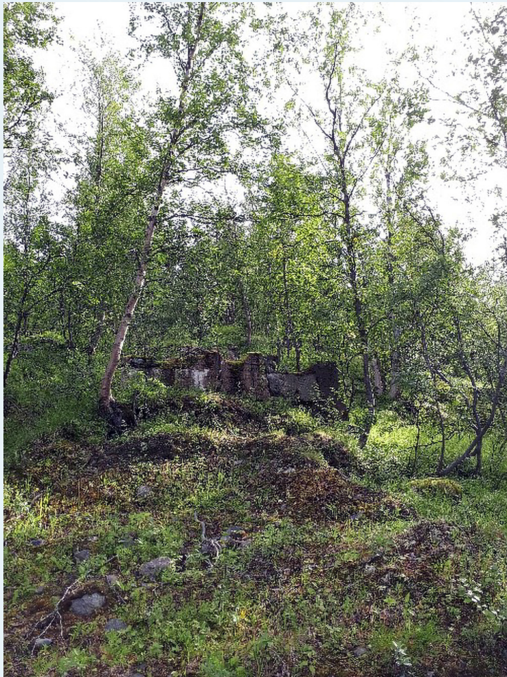
Gamle fundamenter for rørgate i Porsa.
